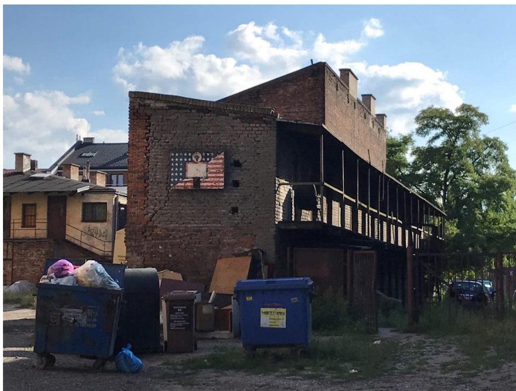
Zdjęcie 7. Zaniedbane komórki gospodarcze, brak estetycznego rozwiązania składowania odpadów
